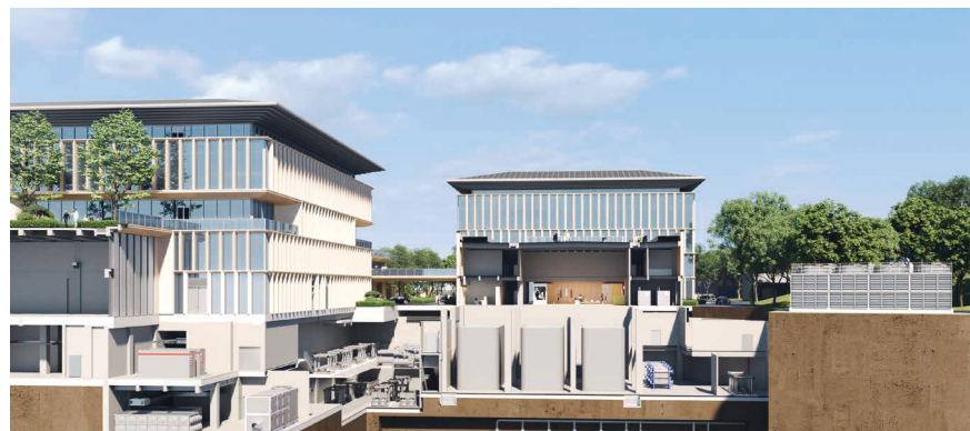
白马湖园区综合能源一站式供应项目
