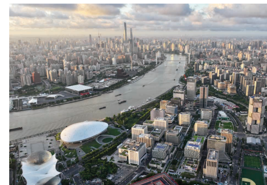
上海世博A片区能源中心
