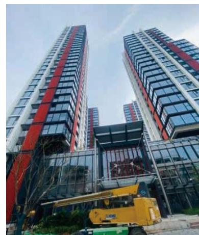
中兴路1号项目立面实景图
